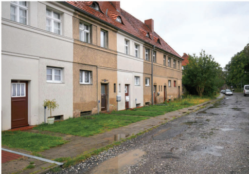
Zweigeschossige Wohngebäude im unterschiedlichen Sanierungsstand, 2009
