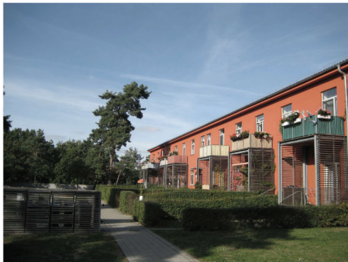
Sanierte und in Wohnraum umgewandelte ehem. Flak-Kaserne, 2009
