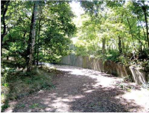
Untertunnelung vor dem ehem. Empfangsgebäude, 1936
