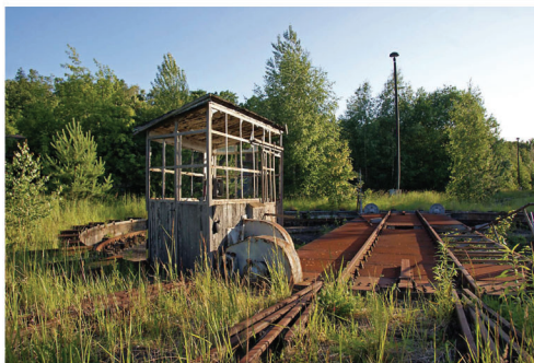
Relikte der Stellwerks- und Gleisanlagen, 2005
