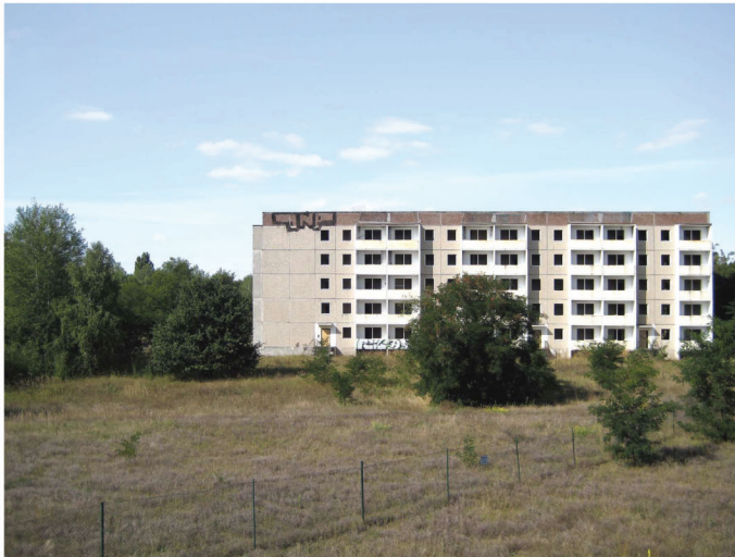
Ergänzungsbau der WBS 70, zwischen 1980 und 1983 auf dem Gelände des ehem. olympischen Dorfes errichtet, 2009
