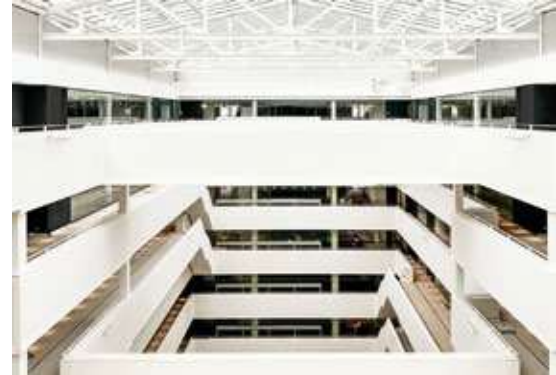
7 Bramfeld OTTO GOeast Gebäude 4 – Umbau einer Logistikhalle zu einem Bürogebäude
