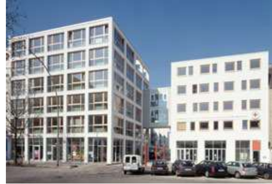
34 Eimsbüttel Karl Schneider Passage (2001)
